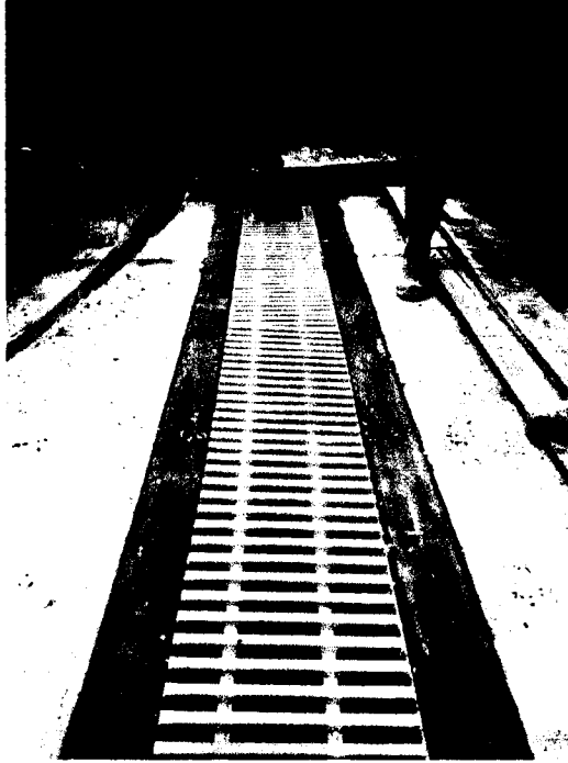
Instalación ángulos y rejillas de fibra de vidrio
